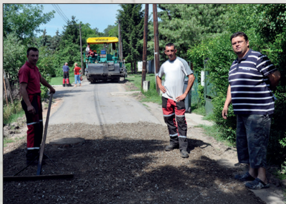
Az utak felújítása is megtörtént
