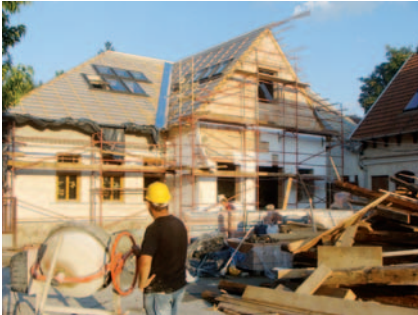
Szorgos kezek munkálkodtak az épületrészben
